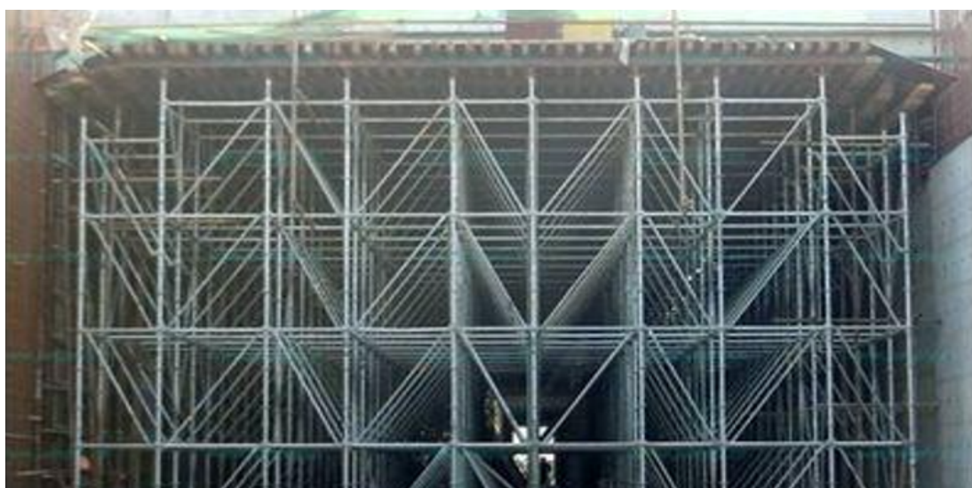
50 系列组合式带肋塑料模板+独立支撑体系（导墙模板）
