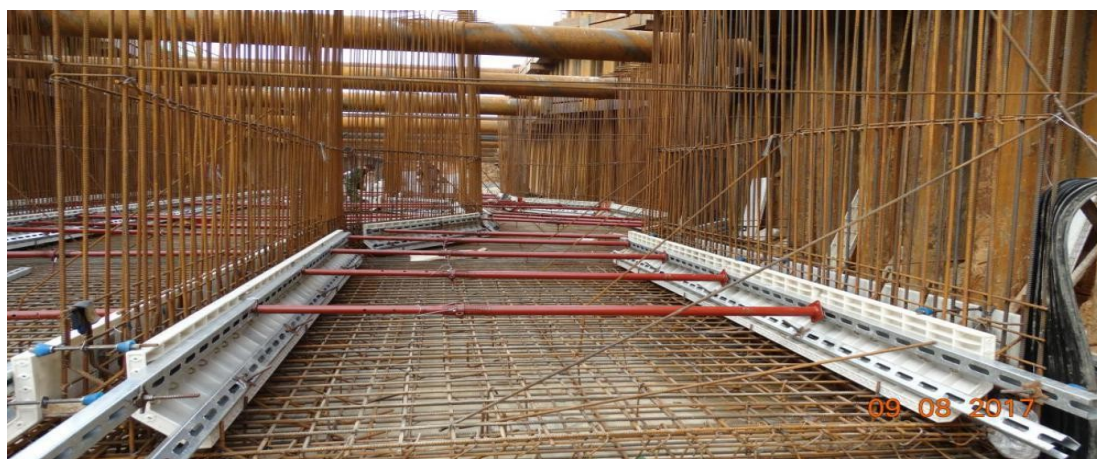
50 系列组合式带肋塑料模板+独立支撑体系（壁板、顶板模板）
